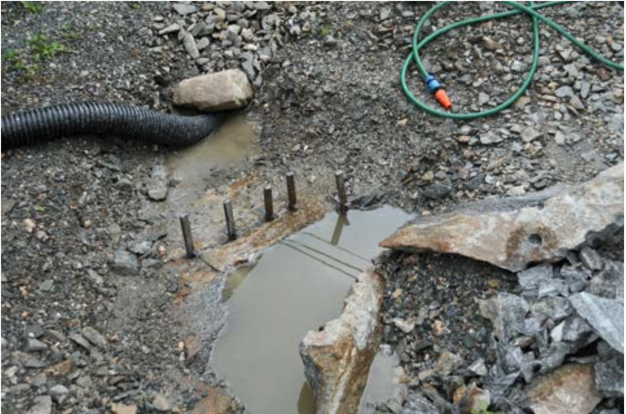
Dreneringsrøret har kommet til en forhøyning. Kile og blekk brukes for å fjerne en skål på tunet.
